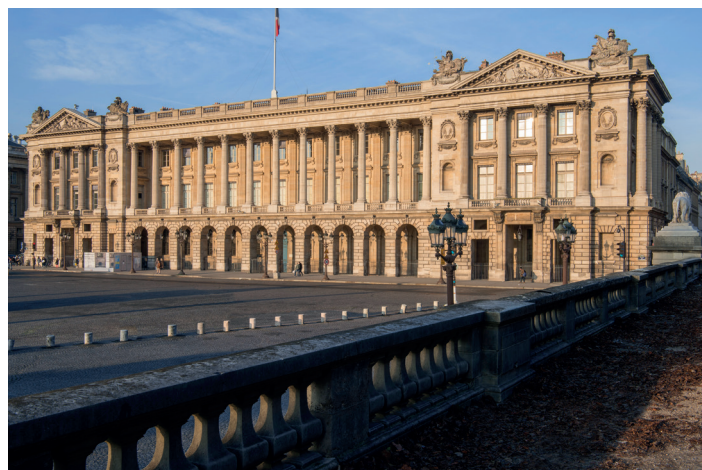
Façade depuis la place de la Concorde
